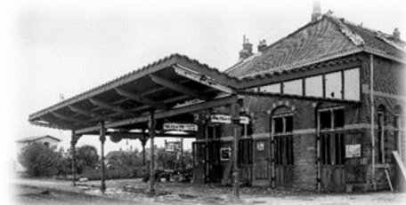
Het zwaar beschadigde station in 1945.
